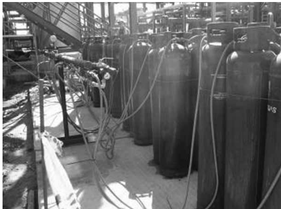
Obrázok č. 3 - Zapojenie 33 kg fliaš do mobilnej batérie na stavbe
