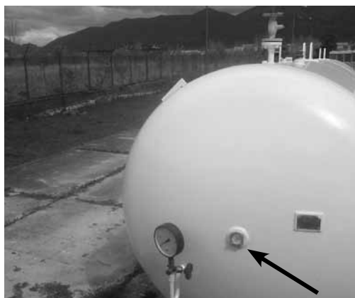
Na zásobníkoch s objemom 9 000 L, 13 000 L a 17 000 L môže byť hladinomer osadený aj na bočnej strane zásobníka.
